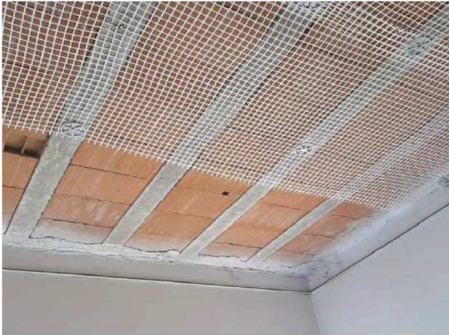
FASE 2: FISSAGGIO RETE IN FIBRA DI VETRO AR MEDIANTE FLANGE IN NYLON
